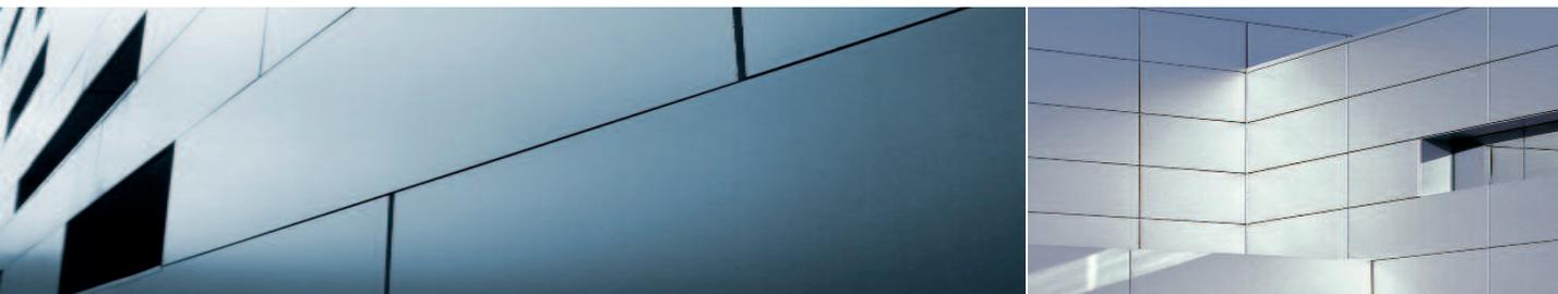
**hm-falzit® structur** Farbaluminium in Doppelstehfalzqualität ist ein Aluminiumwalzprodukt, das im Coil-Coating-Verfahren mit einem Strukturlack bandbeschichtet wird. Die Legierung, die mechanischen Werte und das Lacksystem sind speziell für die Weiterverarbeitung in Falztechnik abgestimmt.
