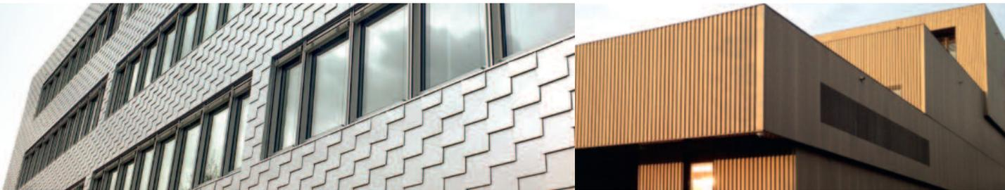
**hm-eflex** ist eine innovative Form der modernen Bandeloxierung. Die hier erzeugte metallische Oberfläche ist funktionell und begleitet Materialverformungen ohne wesentliche Beeinträchtigungen der Eloxalschicht.
